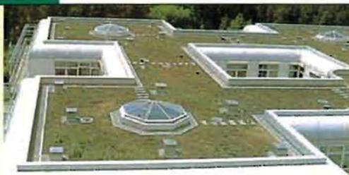
Vegetazione senza particolare esigenze di manutenzione e resistente alla siccità, ridotta varietà di specie: muschio, sedum e piante erbacee perenni (100 kg/mq).
