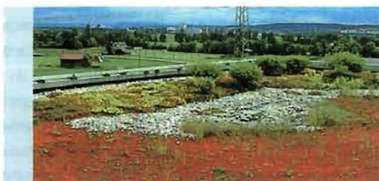
Un prato fiorito di semplice manutenzione eterogeneo, ecologicamente perfetto (peso 150 kg/mq) con piante perenni erbacee e aromatiche, senza particolari esigenze di manutenzione.
